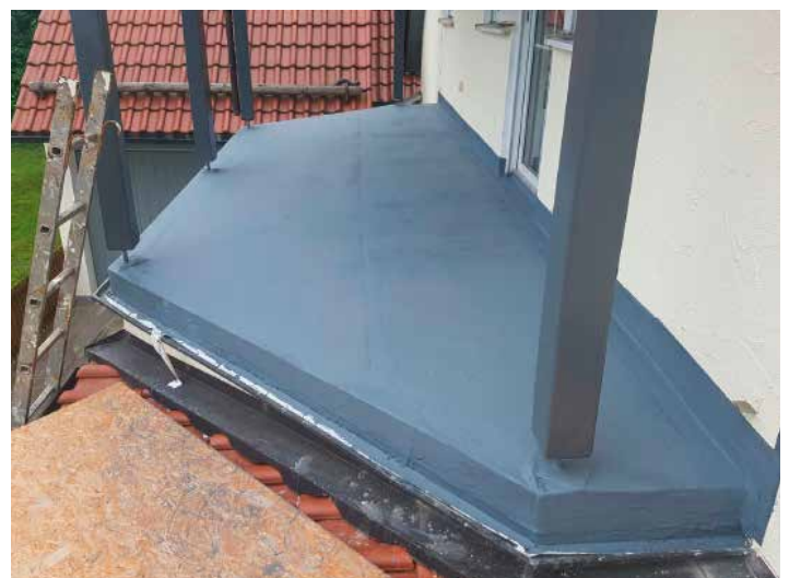
Schichtaufbau ECO FLEX TOP COAT
